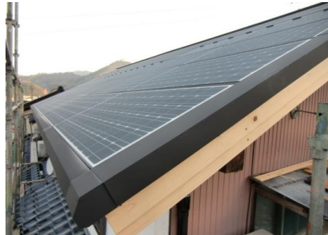
<太陽光発電システム施工>
